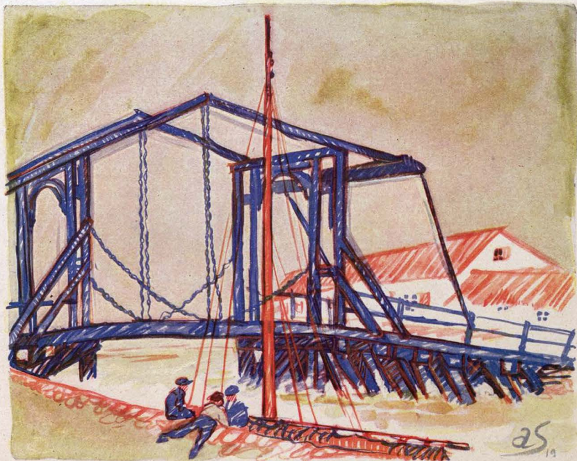
Holzbrücke in Wollin
